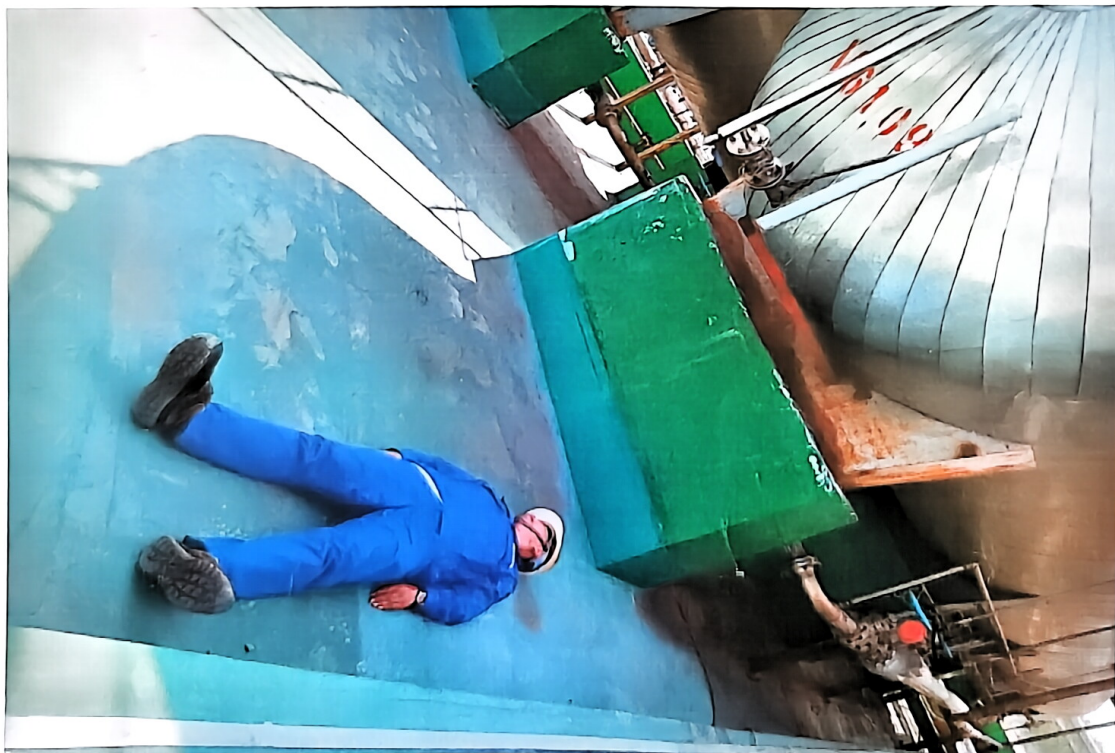
刘感平在罐区报警仪报警异常情况下贸然进入罐区，由于缺氧中毒导致晕倒
