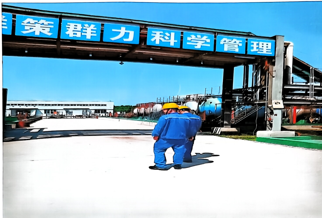
罐区刘感平、杨冠对罐区进行巡检作业
