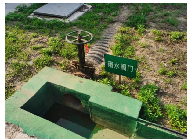
雨水切断阀
