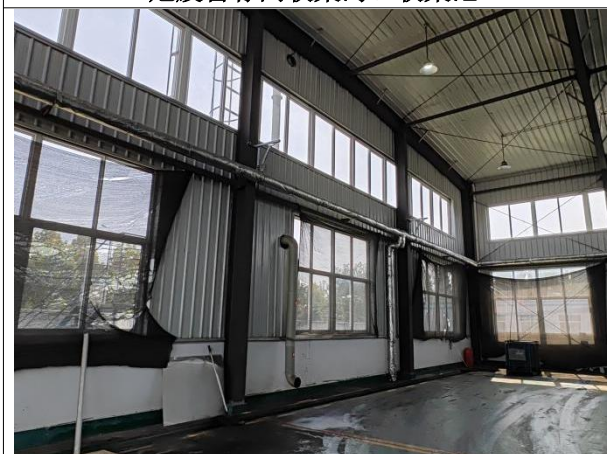
危废暂存间废气收集管道
